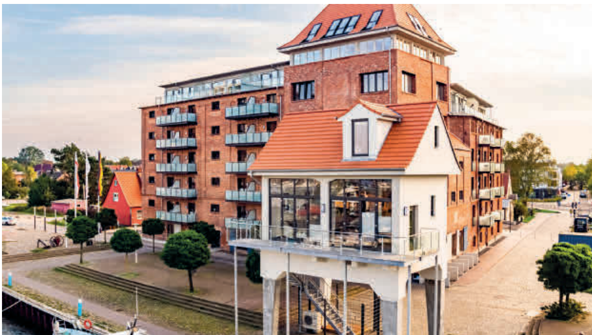
Bei der Umnutzung eines historischen Kornspeichers an der Ostsee wurden unterschiedliche Türen und Hebeschiebetüren verbaut.
