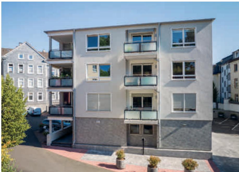
Ein Mehrfamilienhaus mit Fenstern auf Basis von Gealan S 9000 mit Aufsatzrollläden von Beck+Heun.
