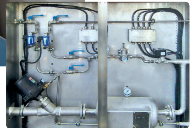
Stickstoffverrohrung
