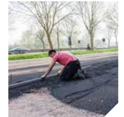
Planen Sie je nach Endanwendung einen Erdaushub ein und verlegen Sie sodann vor der Fundamentschicht ein Geotextil. Bedecken Sie die Fundamentschicht mit einer Ausgleichsschicht und verdichten Sie das Ganze gut. Verlegen Sie dann die Randsteine mit einem Überstand von 1 bis 2 cm über dem endgültigen Kies-/Splittniveau.
