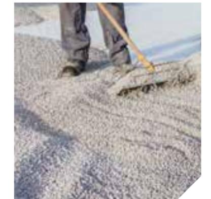
Verlegen Sie die Nidagravel-Platten Kante an Kante mit Kreuzfugen. Das überstehende Geotextil auf beiden Seiten unter der Nachbarplatte anordnen. Eine mechanische Befestigung ist nicht erforderlich. Befüllen Sie die Platten mit Kies/Splitt und bedecken Sie sie in einer Stärke von 1 bis 2 cm. Bei Bedarf nivellieren und verdichten.
