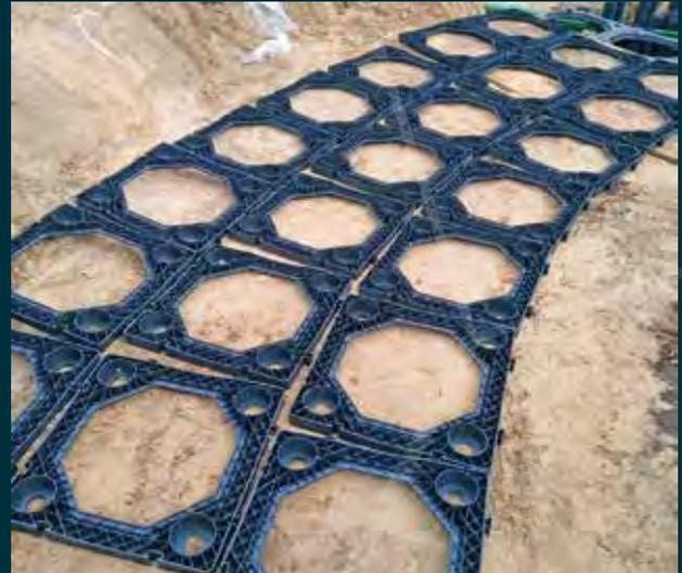
2. Die Rahmen (frames) werden gemäß Layoutzeichnung platziert. Die Einheiten können mit maximal 75 mm Abstand installiert werden, wodurch auch Kurven und abweichende Formate möglich werden. Gesamtgröße max. 675 x 675 mm.
