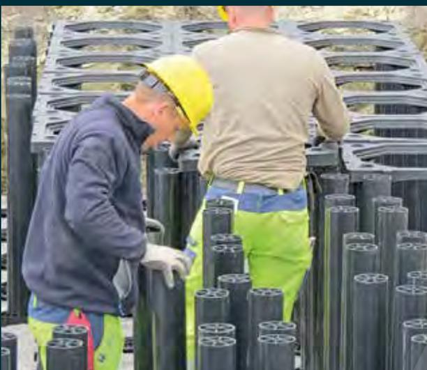
3. Nach Platzierung der Rahmen gemäß Zeichnung werden die Pfosten (posts) eingesetzt und der Abdeckrahmen (frames) installiert. Die Pfosten sind in drei Höhen lieferbar. Sogar während der Installation kann die Höhe noch an eventuelle unerwartete Gegebenheiten angepasst werden.
