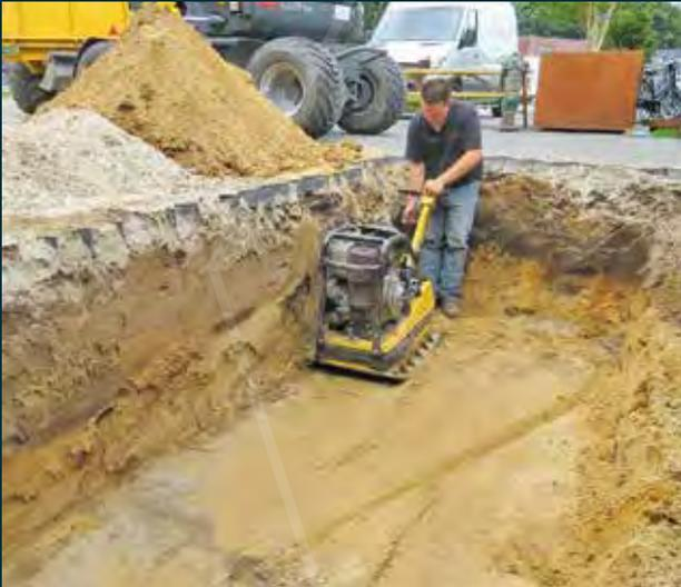
1. Auskoffering der Baumgrube und Vorbereitung des Untergrunds, um die Standsicherheit zu erfüllen.
