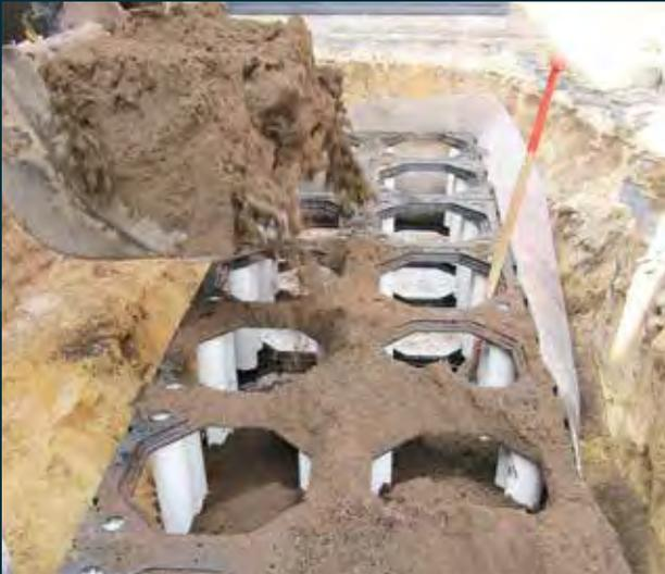
5. Anschließend kann das System befüllt werden. Wichtig ist eine maximale Verdichtung des Bodens um das System. Das Baumsubstrat im System selbst wird nur mit den Füßen leicht verdichtet, damit dem Baum ein maximales Erdvolumen zur Verfügung steht.
